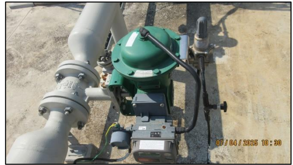
ภาพที่ 2-9 วาล์วระบายความดันที่ท่อเผา/วาล์วฉุกเฉิน
