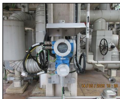
ภาพที่ 2-36 ติดตั้งบล็อกควาล์วที่ท่อ และเครื่องตรวจวัดอัตราการไหล
