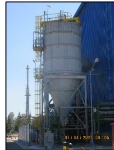
ภาพที่ 2-4 เครื่องดักฝุ่นแบบ Bag Filter
