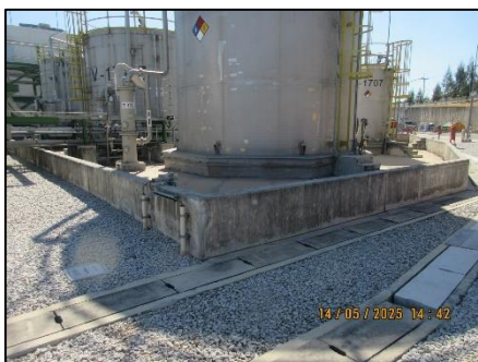
ภาพที่ 2-33 คันกันคอนกรีตล้อมรอบลานถังเก็บกาก
