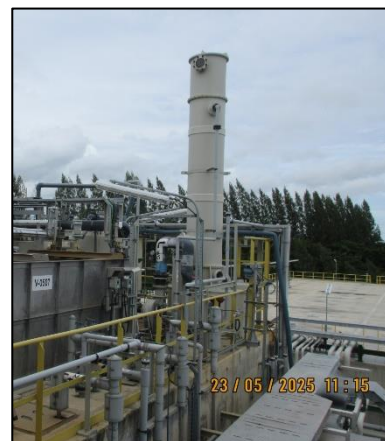
ภาพที่ 2-15 หน่วยบำบัดกลิ่นแบบสครับเบอร์ จำนวน 2 ชุด
