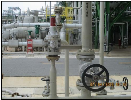
ภาพที่ 2-9 วาล์วระบายความดันที่ท่อเผา/วาล์วฉุกเฉิน
