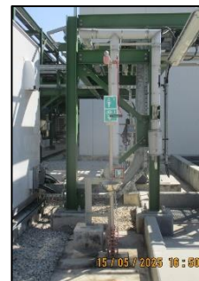
ภาพที่ 2-29 อ่างล้างตาและร่างกายฉุกเฉิน
